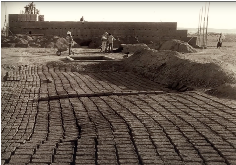
Chantier le l'Escalier céleste, briques de terre séchée au soleil.
