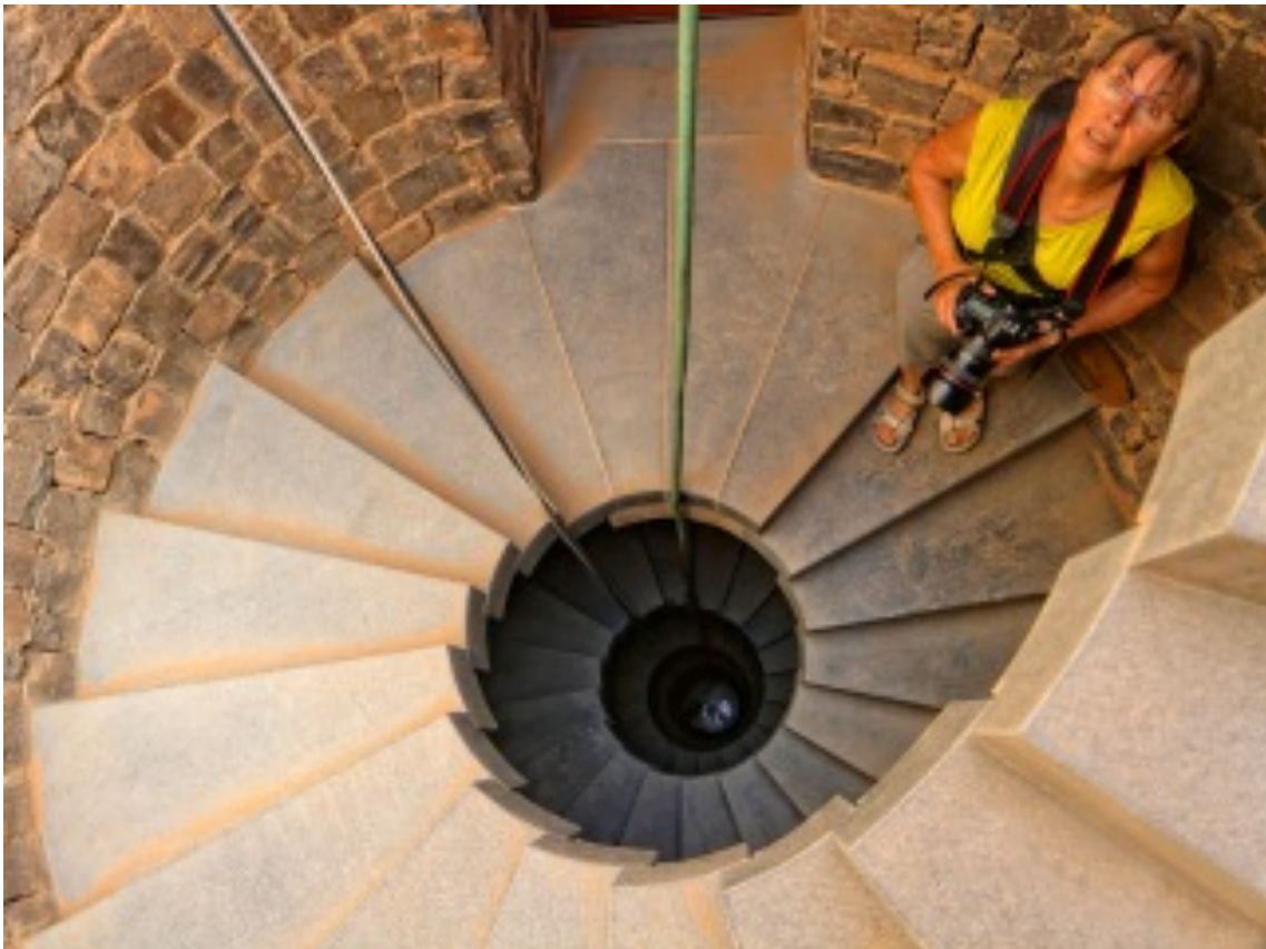
Paroi du puits en roche et marches en marbre.
