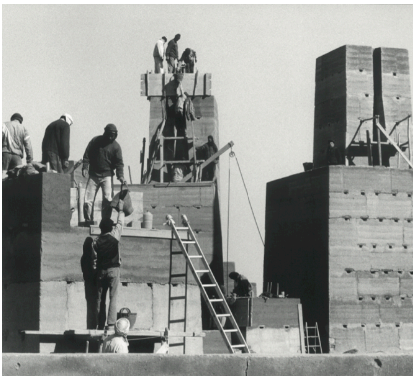
Le chantier en terre de la Cité d'Orion.
