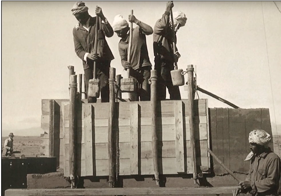
Chantier de l'Escalier céleste, mur en pisé banché.
